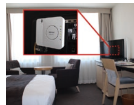
「WAPS-1266」をテレビ裏側に設置することで客室内の景観を維持
